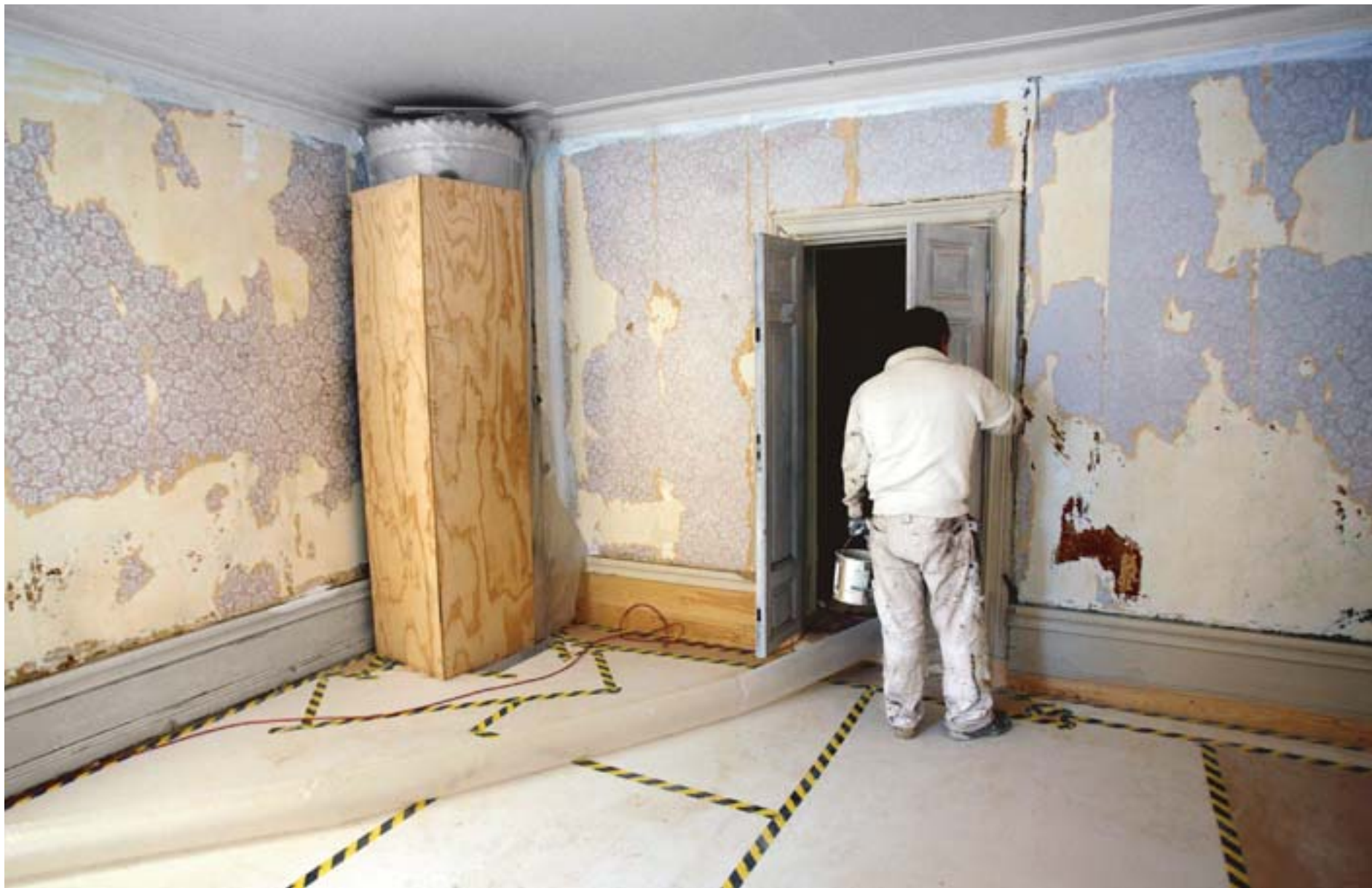
SKÖNT CHARMIGA MEN DYRA I DRIFT. Bara i år planerar Stadsholmen renovering och underhåll för 101 miljoner. På Malmgårdsvägen jobbar ett 30-tal hantverkare med allt från rördragning till murarbeten. Men någon lyxrenovering är det inte tal om. Huset har flera hundra år på nacken – och det ska synas. FOTO: ANDREAS ENBUSKE
